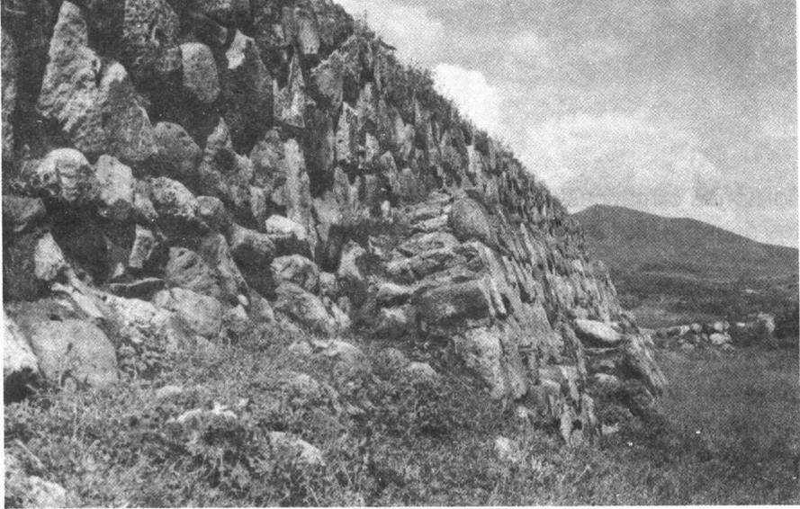
Figura 19. Muros de contención superpuestos.
